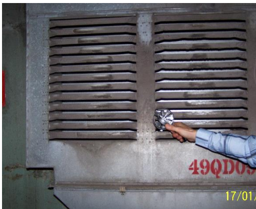
Визначення швидкості повітря припливної вентиляції
