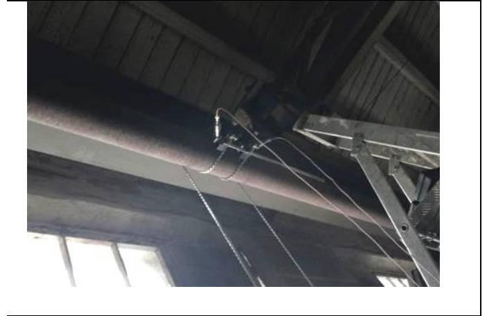
Вимірювання витрат води на окремих ділянках водопроводів за допомогою ультразвукового витратоміра
